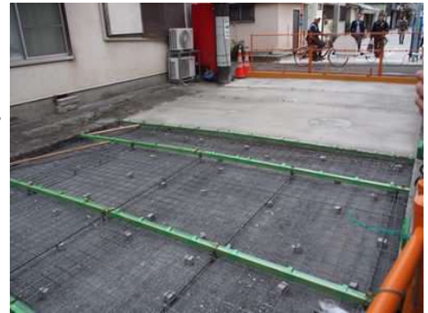
住吉稲荷前の舗装工事
