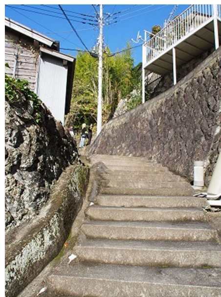
階段から見えるのは階段と擁壁
