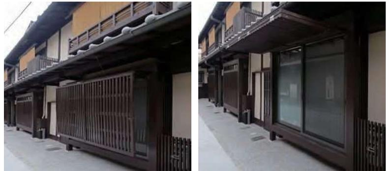
写真4 出格子開閉時の様子（左：半開放、右：開放）
