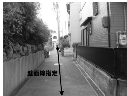
西側から計画路地を見る
