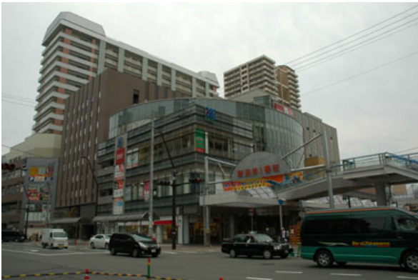
駅前広場側からアスタプラザファーストを見る
