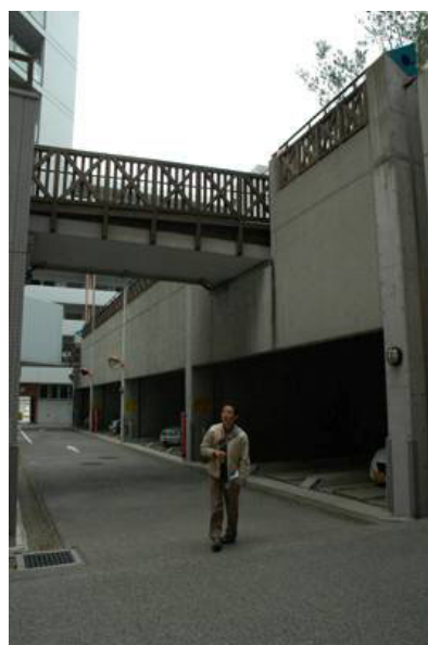
裏側の駐車場（屋上緑化）
