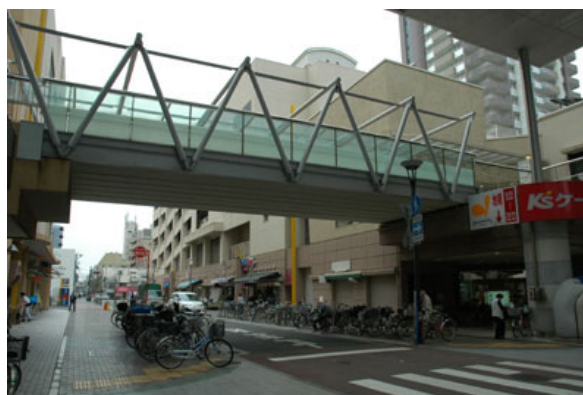
街区と街区をつなぐデッキ
