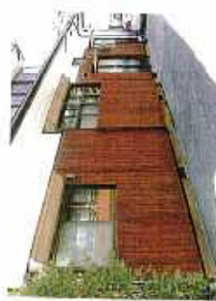
【改修後】 新築の民家の外観。モルタル目地とタイル目地。
