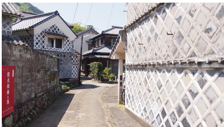
この集落はなまこ壁が比較的多く残っている
