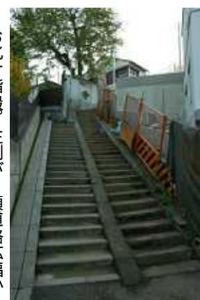
お化け階段。左側が2項道路拡幅か？
