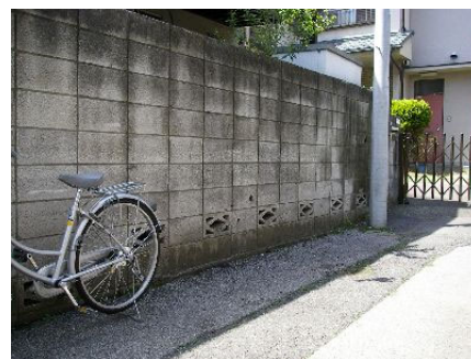
ブロック塀従前
