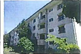
▲北側(階段室側)
