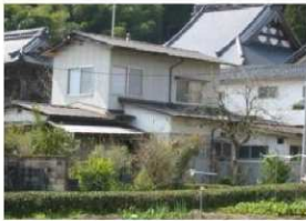
江津市定住促進集落活性化住宅 市山第一住宅
