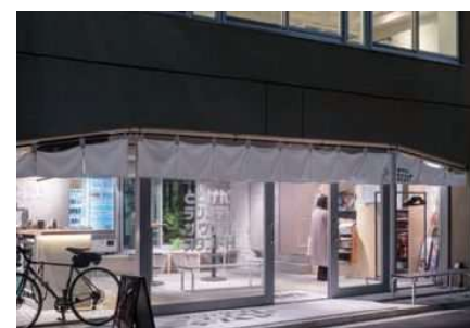
鉄筋コンクリート造北東タ景。1階にランニングステーションが入る。
