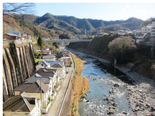
桂川(新大月橋から)、危険な住宅群
